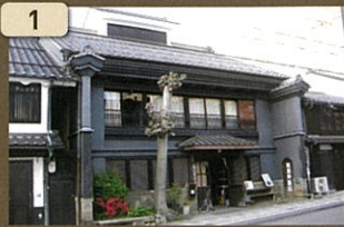
1 旧小諸銀行 大正初期、小諸では小諸銀行などの銀行が製糸金融を支えた。両側の防火壁・うたが見もの。
