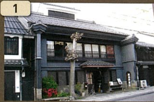
1 旧小諸銀行 大正初期、小諸では小諸銀行など3つの銀行が製糸金融を支えた。両側の防火壁・うだつが見もの。
